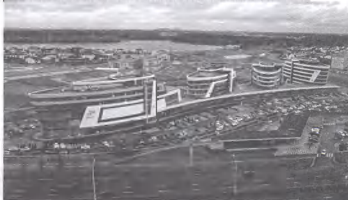
МНОГОФУНКЦИОНАЛЬНЫЙ БИЗНЕС-ЦЕНТР «RIVIERA PLAZA» В МИНСКЕ (УП «ТВОРЧЕСКАЯ МАСТЕРСКАЯ АРХИТЕКТОРА Б. Э. ШКОЛЬНИКОВА», 2014–2016)
