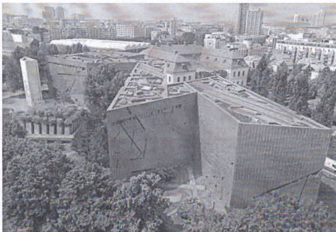
Рис. 3. Здание Еврейского музея в Берлине (1989–1999, арх. Д. Либескинд) Pic. 3. Building of the Jewish Museum in Berlin (1989–1999, arch. D. Libeskind)
